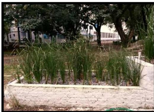
**Figura 1. Sistema 1 construído em alvenaria**
